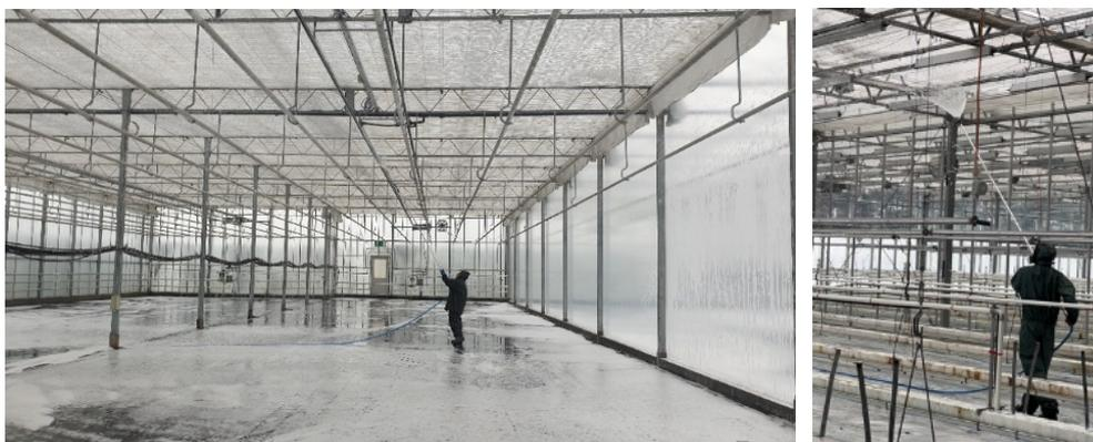
Figura 3. Disinfezione di una serra di grandi dimensioni dopo la rimozione di tutti i substrati di coltivazione e di tutti gli elementi smontabili (foto a sinistra, Servizio fitosanitario del Canton Turgovia, Arenenberg). Trattamento di una serra di medie dimensioni con disinfettante schiumogeno (foto a destra, Agroscope Cédric Camps).
