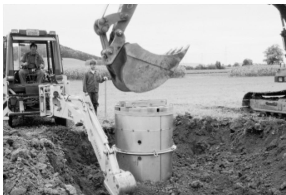
Fig. 1: Un excavateur a placé des cylindres en acier chromé d'un diamètre de 113 cm (surface de 1 m 2 ) à 1,5 m de profondeur dans le sol. Ces dispositifs de mesure, appelés lysimètres, servaient à recueillir l'eau de percolation et à l'envoyer dans un collecteur de manière à déterminer la lixiviation des nitrates.
