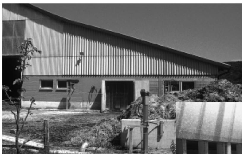
Abb. 1: Umwandlung eines Anbindestalles in einen Laufstall durch seitlichen Anbau einer Liegehalle.
