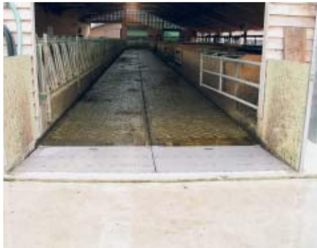
Fig. 19: Pour que les machines puissent circuler sur la voie d'évacuation du fumier, il faut qu'il n'y aucune marche ni degré. Des tôles-passerelles, qui servent également de clôture, peuvent servir à fermer le trou d'évacuation pendant le passage des machines.
