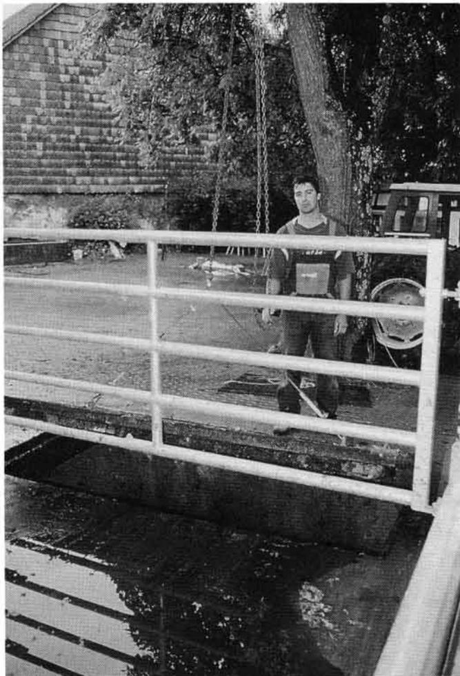
Abb. 19. Durch das Anordnen des Abwurfes ausserhalb der Einzäunung können Tiere während der Reinigungsarbeiten nicht in Gefahr kommen (Foto BUL).
