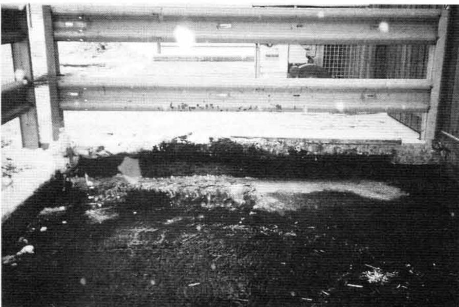
Abb. 18. Der Direktabwurf in die Güllegrube ist vor allem für das Arbeiten mit Schiebern ideal. Es sind keine zusätzlichen Sicherheitsvorkehrungen notwendig.
