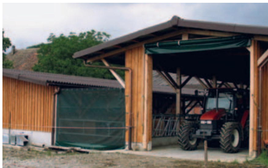
Abb. 9: Bei einem offenem Stallgebäude reduziert ein Windschutznetz im Auslauf die Luftgeschwindigkeit.
