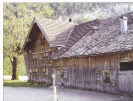
Appenzeller Kreuzfirsthof. Die Verschalung an der Traufseite des Wohnhauses wurde als Witterungsschutz über die Giebelseite hinausgezogen.
