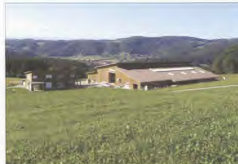
Betrieb Furrer, ZH. Durch die einheitliche Verwendung der Aussenhautmaterialien, der Dachform und Farben bilden der Stall und das Wohnhaus ein einheitliches Ensemble. Dachform, -neigung und Eindeckungs-material sind für beide Gebäude gleich. Dadurch werden die beiden Gebäude zu einer Einheit zusammengeführt.
