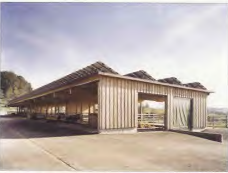
Photovoltaikanlage als Teil des planerischen Konzepts.
