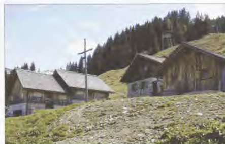
Alpe Grabser, Vlb. Der Steinsockel und die Dachflächen der Gebäude verbinden sich harmonisch mit ihrer Umgebung.
