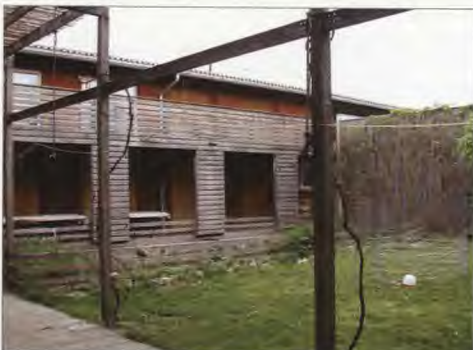
Betrieb Vetter, Vlb. Die Gebäudeflügel bilden geschützte Innenbereiche für die Wohnnutzung und Tierhaltung.
