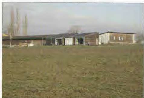
Betrieb Weilenmann, TG. Das neue Haus für die Altenteiler wird durch die bereits beschriebenen Merkmale wie das Baukörpervolumen, die Dachform, aber auch durch die verwendeten Materialien und die einheitliche Farbgebung in das vorhandene Ensemble integriert.
