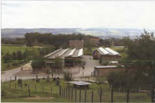
Abbildung 13: Photovoltaikanlage Betrieb Wohn- und Werkhaus Zur Weid, ZH.
