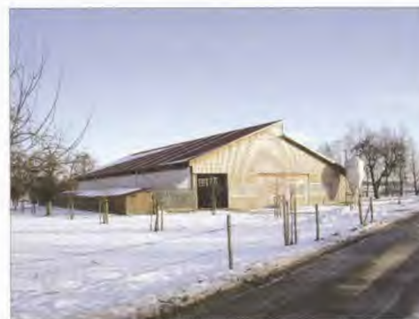
Betrieb Hager, BW. Aus der funktionalen Anforderung für Belüftung und Belichtung ergeben sich die zueinander versetzten Pultdachflächen, die Giebelfassaden werden dadurch gegliedert.
