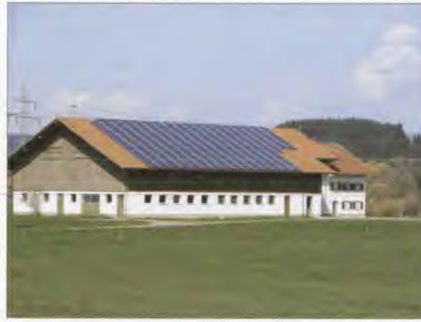
Verteilung der Kollektorflächen auf dem Dach eines Einfirsthofes ohne planerisches Konzept.
