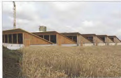
Betrieb Hussel – PigPort für ca. 1.200 Mastschweine, Bay. Die Form und Ausrichtung der Pultdächer ermöglicht, dass die Sonne am Morgen tief in die Abteile scheinen kann. Die schmalen, niedrigen Baukörper fügen sich trotz der großflächigen Überbauung in die Landschaft ein.
