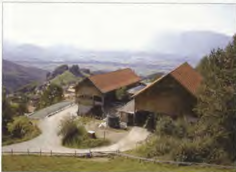
Betrieb Peter, Vlb. Die Wohn- und Wirtschaftsgebäude sind so angeordnet, dass sich sowohl ein geschützter Wohn- als auch Laufhof ergeben.
