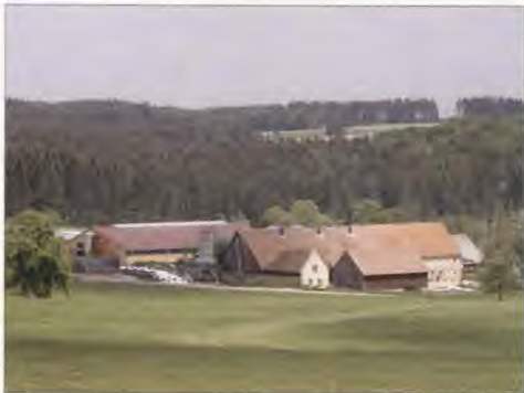
Betrieb auf dem Witthoh, BW. Der neue Rindviehstall ist parallel zum bestehenden Hauptgebäude ausgerichtet und fügt sich somit in das Ensemble ein.
