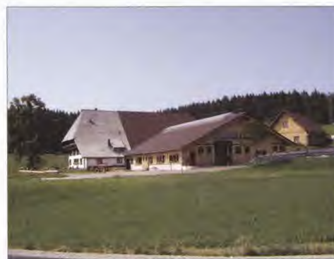
Betrieb Haldenmathisenhof, BW. Der Queranbau ordnet sich in seinem Volumen dem großen Altbau unter.
