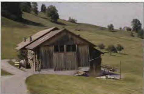
Betrieb Mettler, AR. Die neue Remise, in der im unteren Geschoss die Liegehalle für das Jungvieh untergebracht ist, ordnet sich in ihren Dimensionen dem Bestand unter. Durch die Verwendung der gleichen Gebäudeausrichtung, Dachneigung und Materialien fügt sich das neue Gebäude mit dem Bestand zu einem harmonischen Bild.
