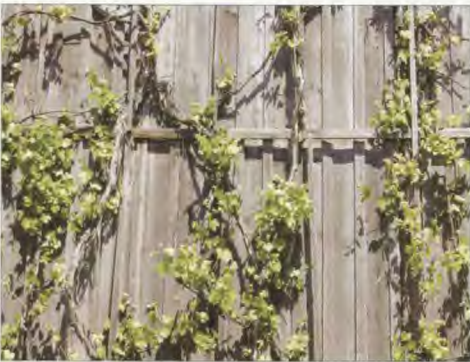
Spaliere gliedern neben Öffnungen, unterschiedlichen Materialien oder einer Farbgebung eine Fassade.
