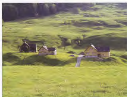
Bauernhöfe im Appenzell, CH. Der Standort der Höfe im Appenzell wurde auf der Hügelkuppe gewählt, die Wohnhäuser sind zur Sonne hin orientiert. Im Appenzell ist der Typus des Kreuzfirsthofes weit verbreitet, bei dem der First des Ökonomiegebäudes senkrecht zum First des Wohnhauses steht.
