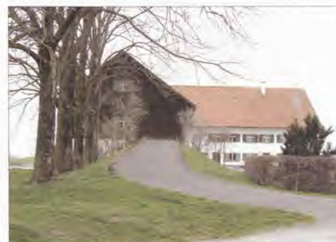
Die Zufahrt zur Tennenauffahrt und die Baumreihe bilden eine räumliche Einheit.
