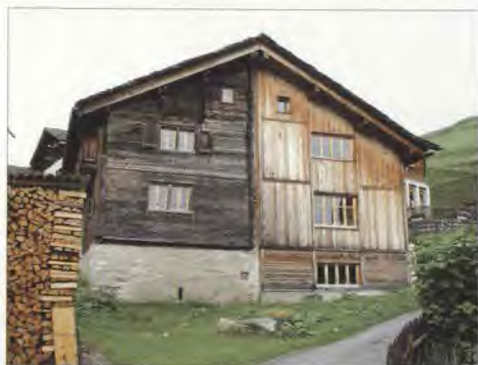
Wohnhaus, GR, mit materialgerechtem Anbau. Detail und Verarbeitung des Materials Holz am neuen Gebäudeteil unterscheiden sich vom Bestand. Die historische Architektursprache wird nicht kopiert, sondern zeitgemäß umgesetzt.
