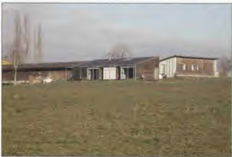
Betrieb Weilenmann, TG. Das neue Wohngebäude für die Altenteiler passt sich in Grösse und Formensprache dem Bestand an.
