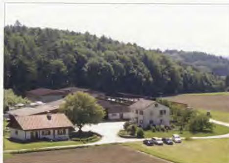
Betrieb Sonnhof, BW. Neben der Lage am Waldrand wird die Verbindung zwischen Gebäude und Landschaft durch den Hofbaum verstärkt.
