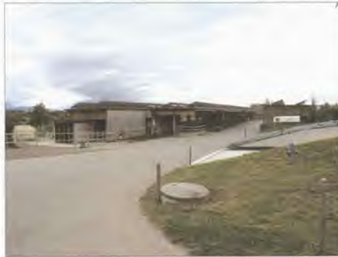
Betrieb Wohn- und Werkhaus zur Weid, ZH. Die einzelnen Gebäude der Hofanlage wurden mit einem Flachdach überdeckt, das für die Installation einer Photovoltaikanlage genutzt wurde.
