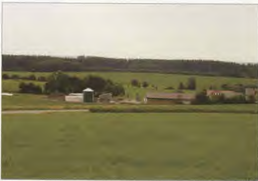
Abbildung 9: Biogasanlage Betrieb Arnold in Dethingen
