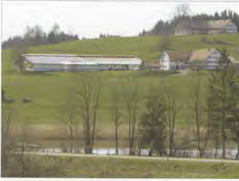
Der Stall steht mit seiner weissen Aussenfassade im Kontrast zur Natur, verstärkt durch die Baukörpergrösse.
