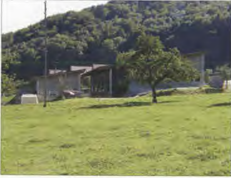
Betrieb Lusti, ZH. Die auf mehrere Gebäude verteilten Funktionsflächen staffeln sich entlang dem flach geneigten Hang.
