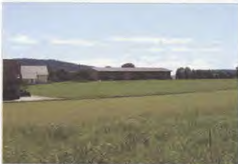
Betrieb B. Hürlimann, ZH. Die Gebäudehöhe ist an den Ort angepasst, so dass der Stall das Ortsbild trotz der großen Länge nicht verändert.
