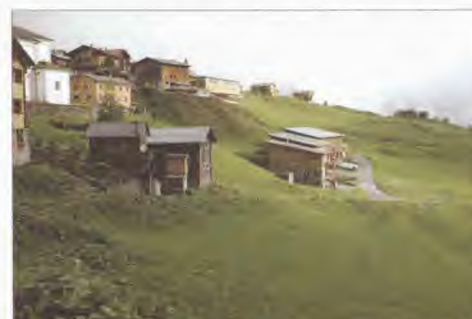
Betrieb Tomaschett, GR. Die Bauten des Ensembles sind entlang der Höhenlinie ausgerichtet.
