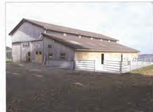
Betrieb Schoch, AR. Das Pultdach über dem Laufstall wurde gegenüber dem Satteldach abgesetzt. Dadurch kann die Tenne belichtet und die Giebelfassade unterteilt werden.
