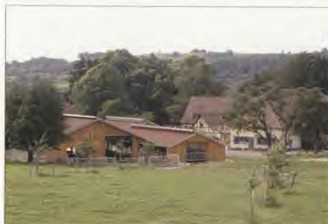
Betrieb Ziegelhütte, BW. Der Laufstall in dem Gehöft wird durch die verwandte Ziegeldachdeckung und ihre Farbgebung mit dem alten Gebäude in Beziehung gesetzt.
