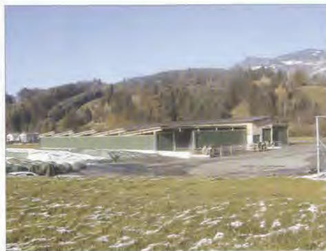
Betrieb Konzett, Vlb. Die Liegehalle des neuen Stallgebäudes ist in mehrere Einzeldachflächen aufgelöst, die auch statisch-konstruktiv über die Futtertischüberdachung zu einer Einheit zusammengefasst sind. Trotz der grossen Tierzahl entsteht eine massstäbliche und gegliederte Anlage.
