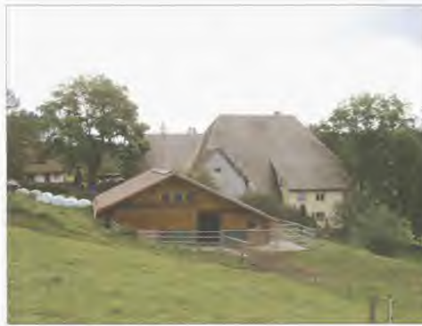
Betrieb Graf, BW. Der neue Mutterkuhstall wurde in den stark geneigten Hang eingeschoben, ohne den Gelände Verlauf zu stören.
