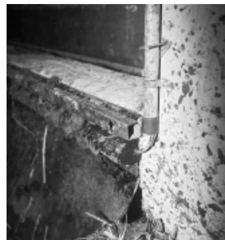
Fig. 21: Les zones d'écrasement au niveau du franchissement des parois constituent une cause fréquente d'accidents. Lorsqu'elles sont montées correctement, les lisses de contact sont efficaces. Un profil de montage suffisamment grand empêche que les animaux ne causent des dommages.
