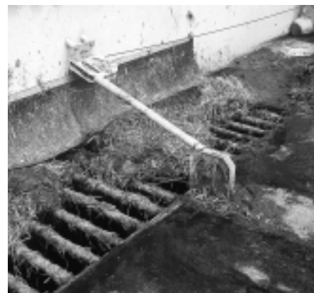
Fig. 12: Sur les grilles réservées au fumier à longue paille, les barres devraient si possible se terminer dans le vide.
