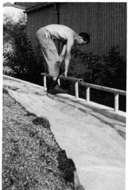
Abb. 4: Das Geländer auf der Ortbetonwand nicht fix montieren! Die Abdeckfolie wird über die Wand gelegt und anschliessend beschwert.
