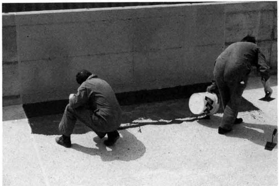
Abb. 3: Streifenversuch an der FAT mit Zweikomponenten-Epoxidharz vermischt mit Quarzsand. Schichtdicke 3 mm, Kosten über Fr. 40.-/m<sup>2</sup>.
