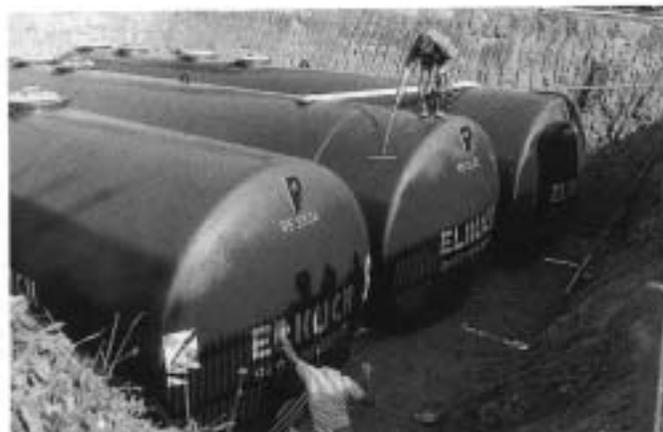
Abb. 4. Die drei Lagertanks für Methanol, Biodiesel und Glycerinphase sind an Ort und Stelle.
