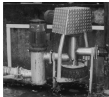
Abb 3: Grüngut-Co-Vergärung: Beschickung des Fermenters mit einer Balgpumpe (in Kombination mit einer Kreiselpumpe).
