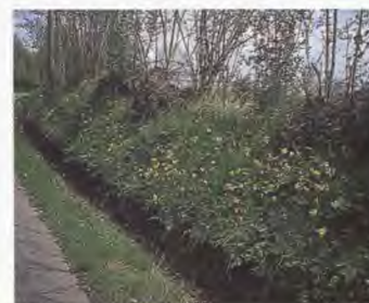
Böschung, Rückzugsraum für Flora und Fauna.
