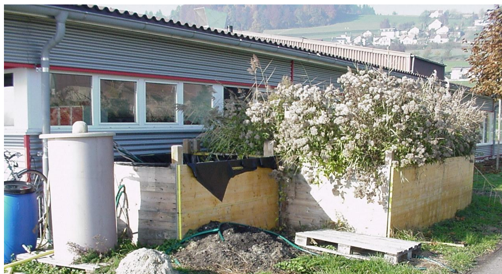
Abb.1: Pilotanlage zur Aufbereitung von Regenwasser (Sandfilter) und Brauchwässern (Schilfklärbetten) im Versuch von VSP und ACW
