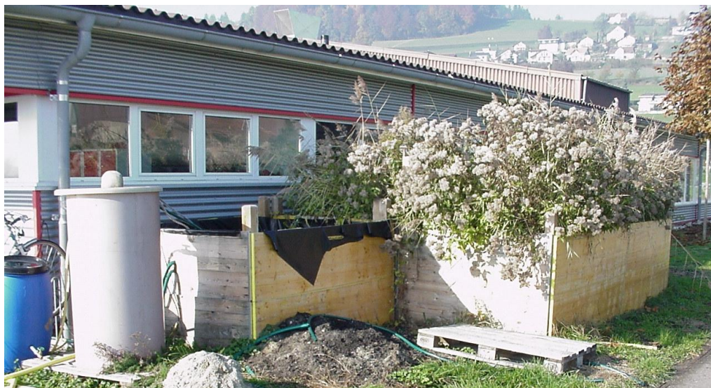
Figure 1 : Installation pilote pour le traitement de l'eau de pluie (filtre à sable) et eau de nettoyage (bassin d'épuration à roseaux) dans l'essai de l'Union VSP et ACW
