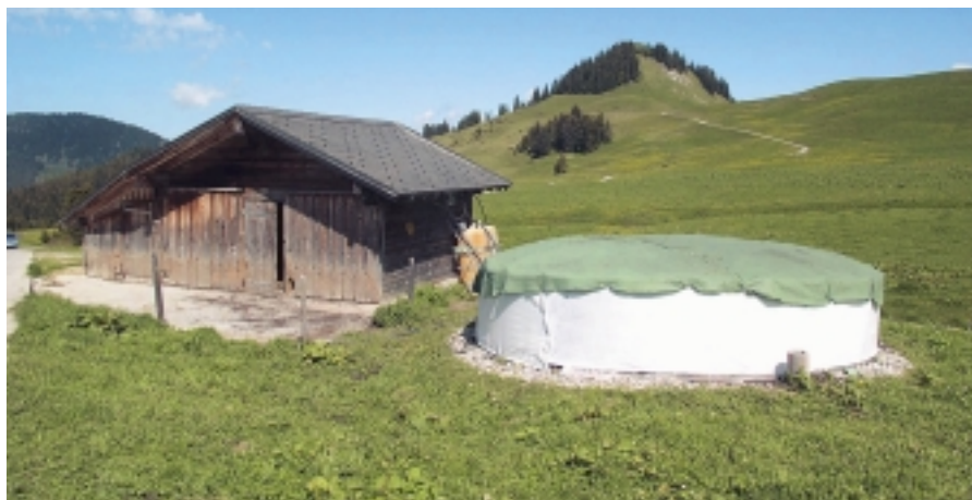
Fig. 3. «Pra Cornet», module de traitement et porcherie.
