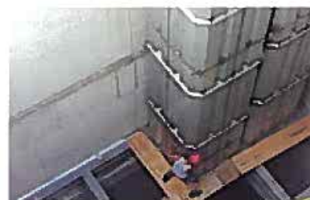
Zelieneinbau nach Beendigung des vierten Stockwerkes war Massarbeit.
