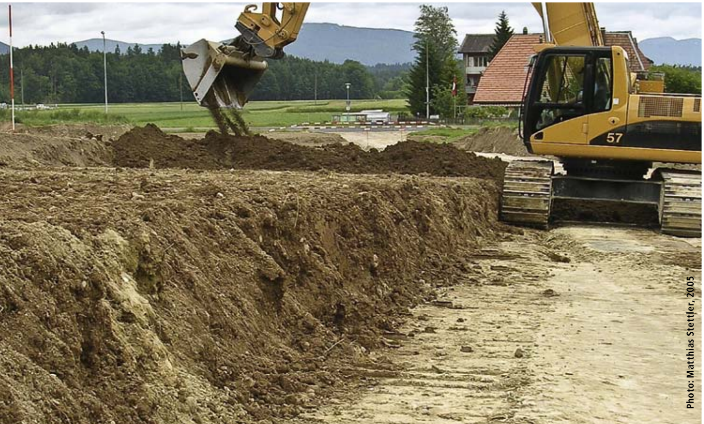
Reconstitution du sol: déversement de la terre superficielle sur le sous-sol préalablement préparé.
