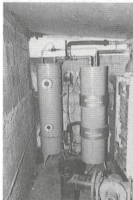
Abb. 4: Entschwefelungsanlage mit zwei Kolonnen für die Reinigung von 50 m<sup>3</sup> Biogas pro Tag.
