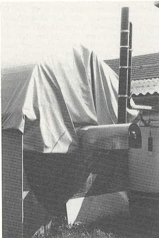
Abb. 3: Zuflusssiphon und Getriebemotor für das Rührwerk.
