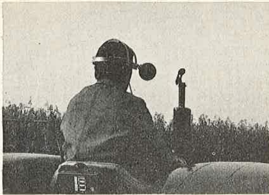
Abb. 2: Lärmmessungen am Ohr des Fahrers mit einer Mikrofon-Haltevorrückung (Foto-FAT).
