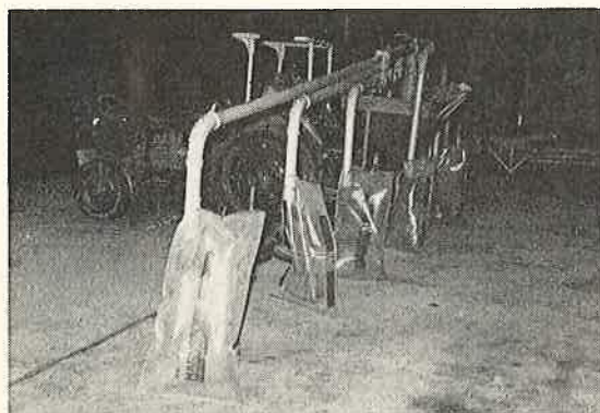
Abb. 1: Ermittlung der Düngerverteilung auf die Streudüsen.
