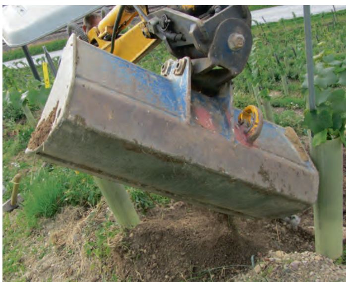
Abb. 11: Hinterfüllung des Netzes mit dem Bagger.
