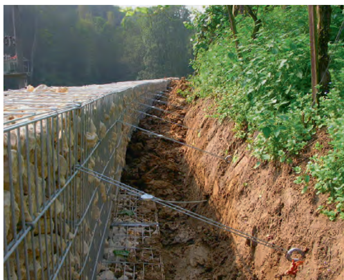
Abb. 12: Verankerte Mauer ist befahrbar.
