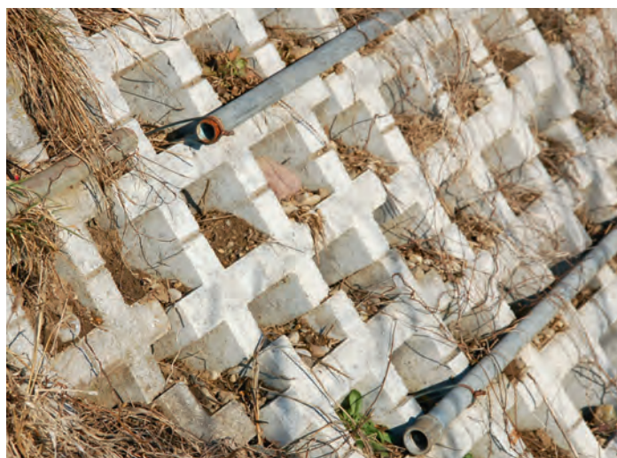
Abb. 6: Durchwachsene Rasengittersteine.
