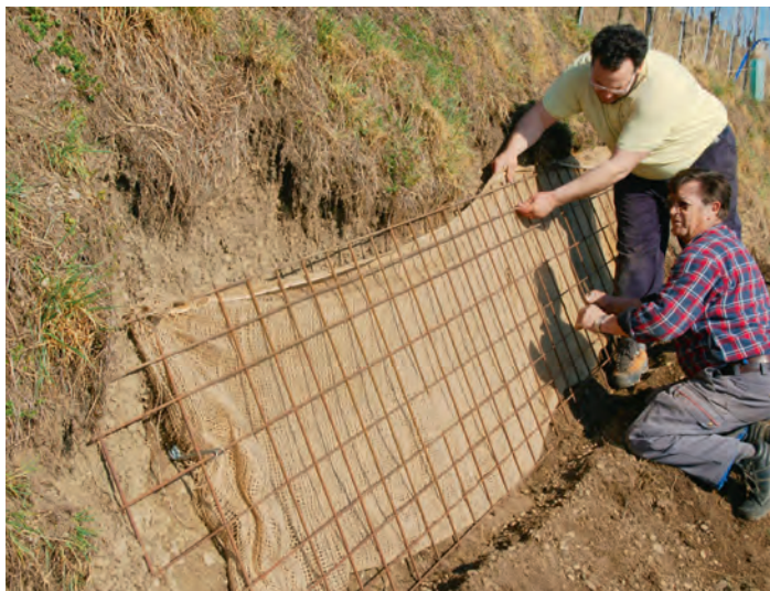
Abb. 7: Gitter mit Jutenetz hinterlegt.
