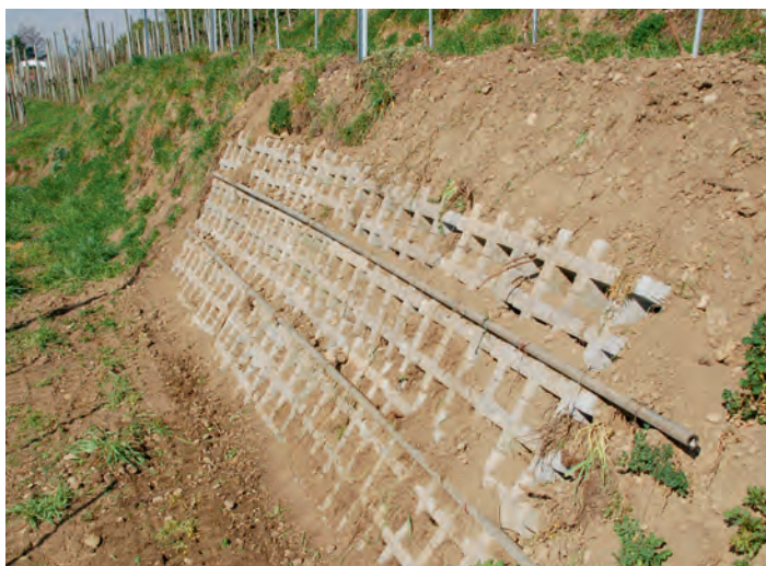
Abb. 5: Rasengittersteine mit Wasserröhren befestigt.
