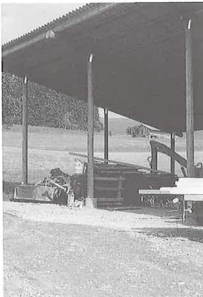
*Fig. 2: Même en cas d'une construction «simple», il faut veiller à ce que les piliers en bois ne soient pas exposés à de l'humidité permanente. Des mesures simples, telles que la protection par un socle en béton, augmentent la durabilité de constructions de ce genre.*
