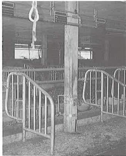
Fig. 4: Pilier préfabriqué en béton, svelte et élégant. Afin de ne pas le blesser, on y a fixé les équipements d'étable au moyen de brides et non pas de chevilles.
