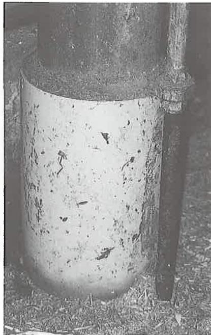
Fig. 6: Pilier en acier avec tuyau protecteur en matière synthétique. La liaison (ici: mortier à couler) doit être impeccable et durable.
