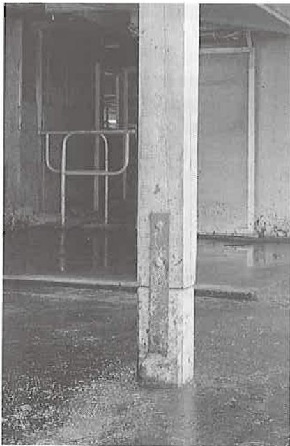
Fig. 8: Pilier en bois dans une cour d'exercice. Le pilier et le socle en béton sont liés à l'aide de deux fers plats fixés latéralement.
