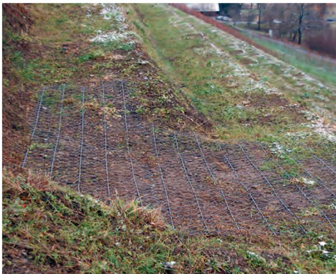
Abb. 2a: Auslegen mit Rasenschutzgitter: frisch verlegt.
