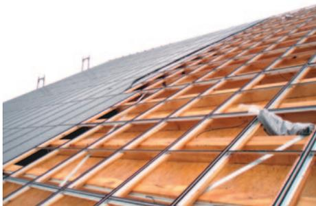
Abb. 13: Dachabsaugung kombiniert mit Fotovoltaik.
