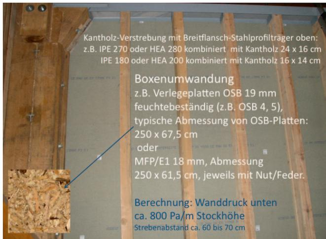
Abb. 4: Ausführung einer Boxenwand.
