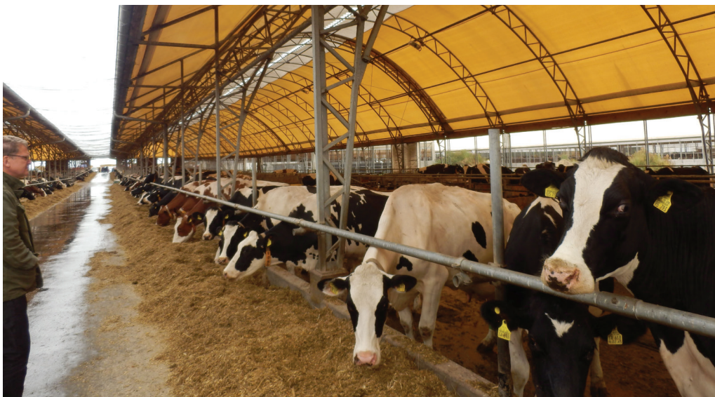
Abbildung 3: Folienstall der Peeneland GmbH in Hohen-dorf (BRD).
