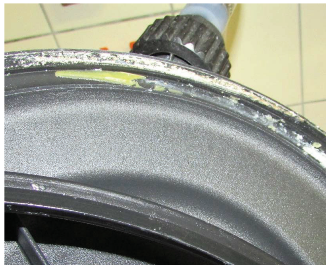
Abbildung 5: Ablagerungen unter Gummidichtung eines Deckels der Endeinheit.
