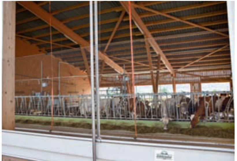
Les stores ou les fenêtres coulissantes permettent d'adapter la surface des ouvertures aux conditions climatiques du moment.
