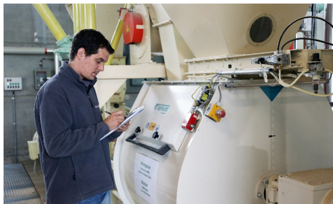
Figure 1: La maintenance et l'entretien corrects des installations sont vérifiés régulièrement.
