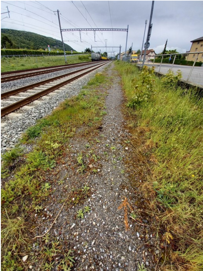
Le Landeron (2021) (Gleiserneuerungsarbeiten 2020 + tägliche Begehung)
