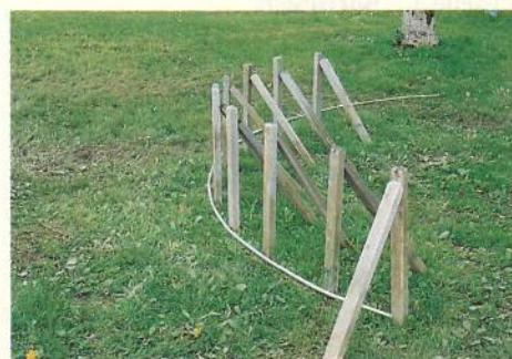
Abb. 3 Das Biegen der Rohre geht einfach mit Hilfe von eingeschlagenen Pfählen.
