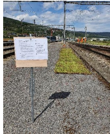
Abbildung 13 : Hinweistafel für das Bahnpersonal. Im Hintergrund die Matten 11 - 15 13: Warntafel in Cornaux
