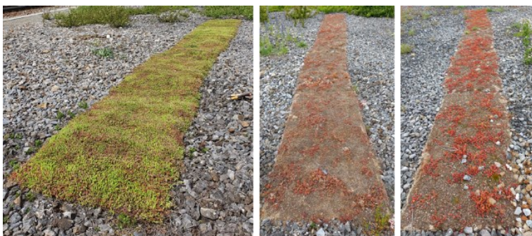
Abbildung 8: Cornaux – Entwicklung der Matten 1 – 5 im Zwischen-gleisbereich auf Schotter. Von links nach rechts: im Mai 2021, im Mai 2022 und im Mai 2023
