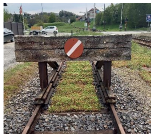
Abbildung 15: Sedum-Matten in Cousset auf Schotter zwischen den Gleisen hinter Prellbock mit den Matten 1 - 4.
