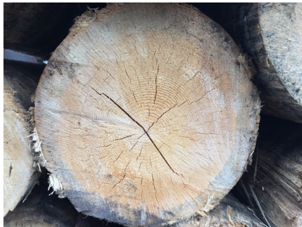
Abbildung 3: Durch Schimmel verursachte Holzbläue
