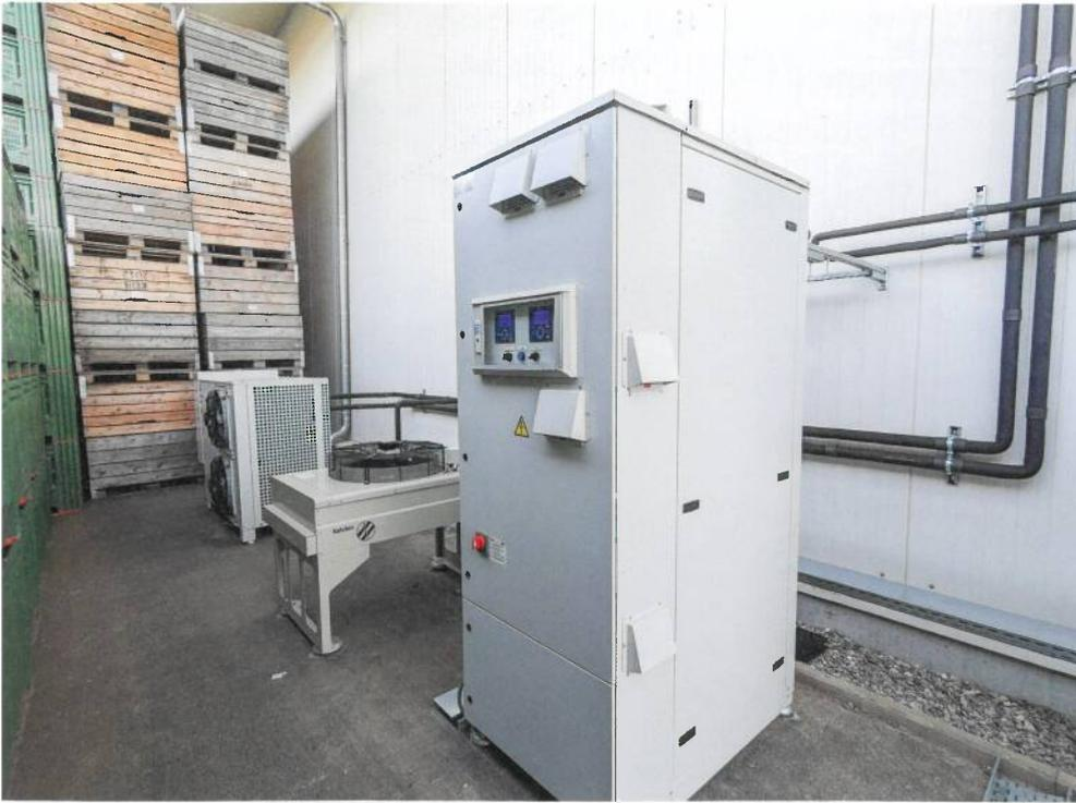
Abb. 3: CO<sub>2</sub>- und Propananlage im direkten Vergleich. (© KOB)
