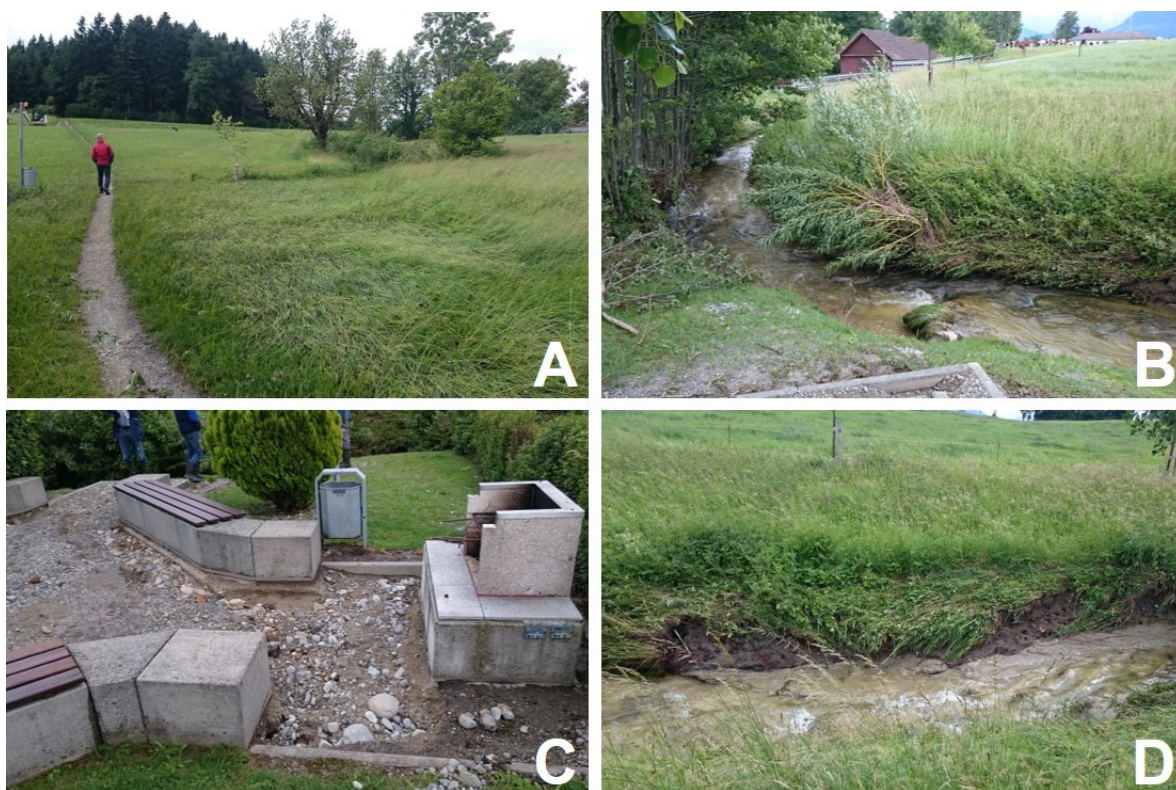
Abbildung 31: Impression von Schäden durch Oberflächenabfluss (04.06.2017) – A: Grossflächiger Oberflächenabfluss, B: Ufererosion, C: Ausgespülter Grillplatz, D: Ufererosion.
