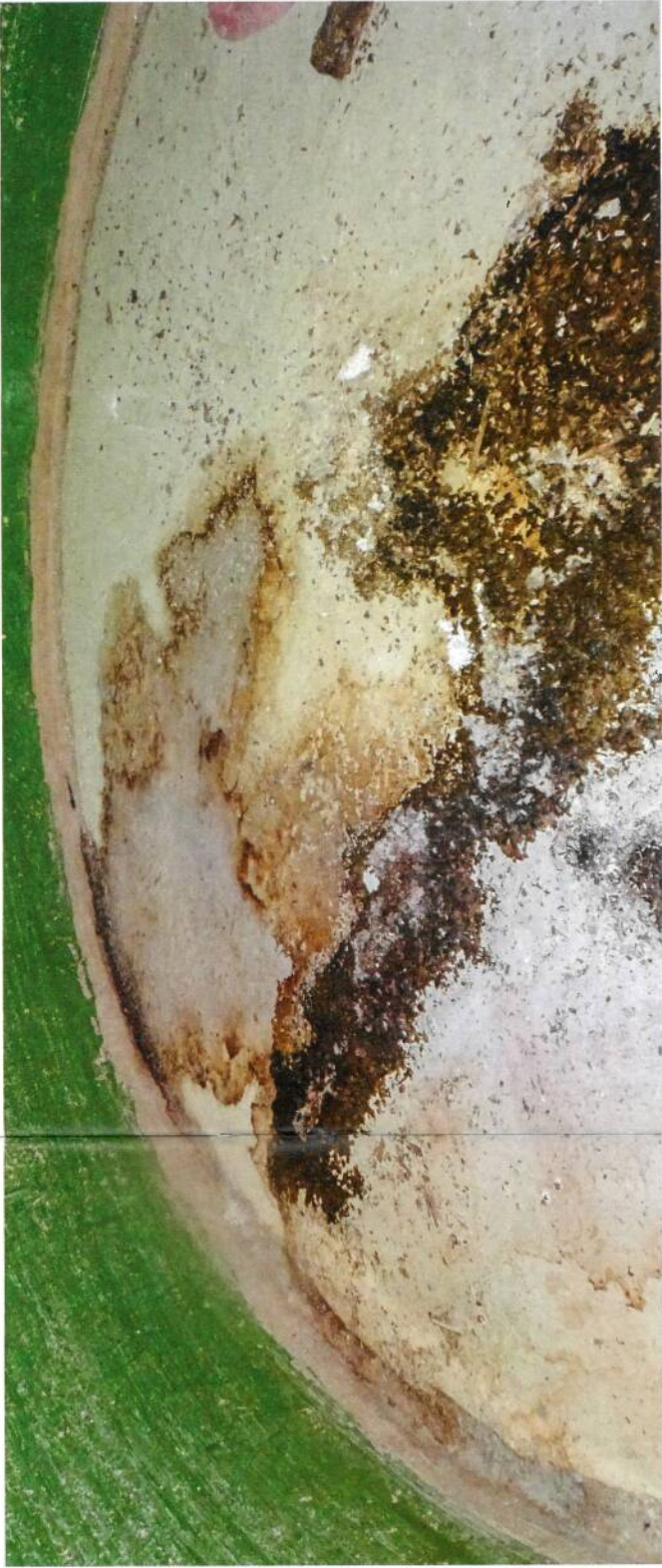
Futterreste im Silo müssen entfernt und Silowände gereinigt werden.
