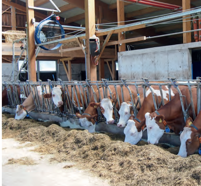
Das Cow Cooling System besteht aus Ventilatoren und Sprinkleranlagen, die über dem Fressgitter installiert sind.
