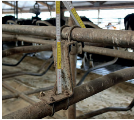
Gewinkeltes Flacheisen mit Verstärkungen als Nackenrohrerhöhung.
