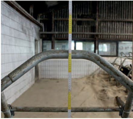
Gewelltes Nackenrohr mit Anfangsstück (links), lichte Höhe in diesem Beispiel 137 cm.
