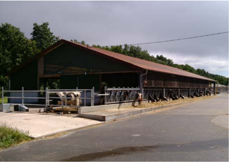
Abbildung 7: Außenansicht des natürlich belüfteten Außenklimastall (Foto: ATB).
