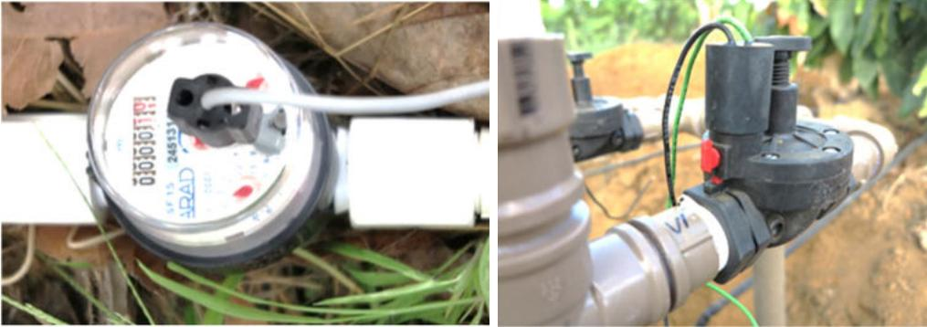
Figura 68: Medidor de fluxo e válvulas elétricas para a irrigação automatizada.
