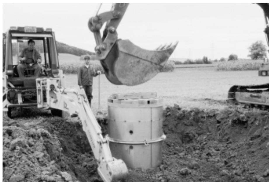
Abb. 1: Ein Bagger trieb Chromstahlzylinder mit einem Durchmesser von 113 cm (1 m<sup>2</sup> Fläche) 1,5 m tief in den Boden. Diese Lysimeter genannten Messeinrichtungen fassen das Sickerwasser und leiteten es zur Bestimmung der Nitratauswaschung in einen Sammelschacht weiter.
