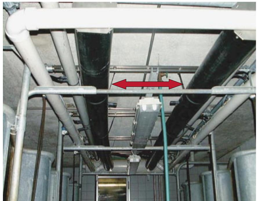
Abb. 4: Speziell eingebaute Puffertanks zwischen Luftleitung und Pulsatoren.
