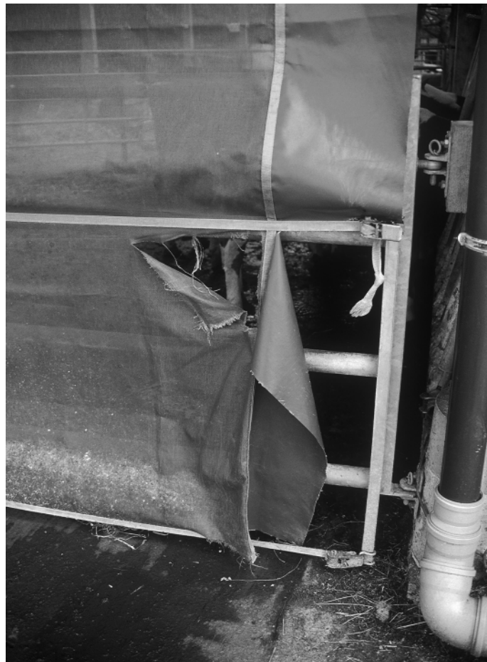
Abb. 9: Werden Windschutznetze ausserhalb der Reichweite von Tieren montiert (links), können Beschädigungen vermieden werden (rechts).
