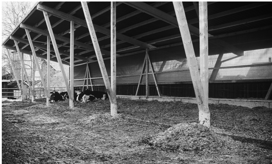
Abb. 2: Unstrukturierte Liegefläche als Liegebett ausgeführt. Ein Vorteil ist die flexible Bauweise, dafür müssen die Kotfladen täglich von der Liegefläche entfernt werden.
