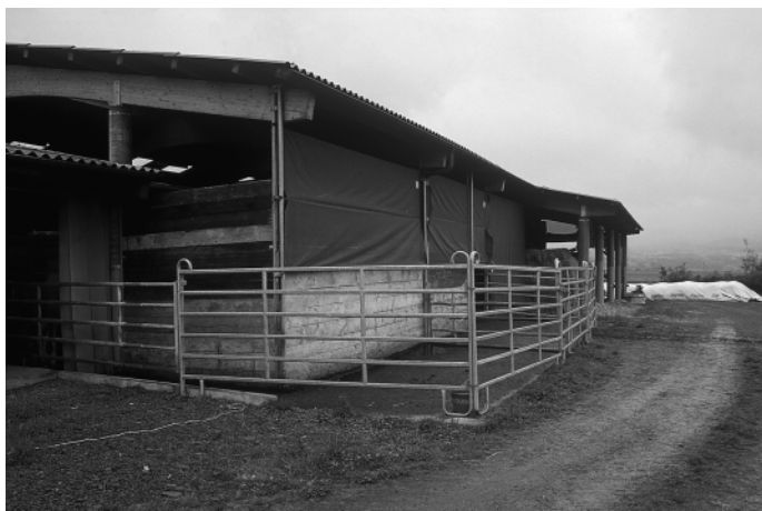
Abb. 9: Werden Windschutznetze ausserhalb der Reichweite von Tieren montiert (links), können Beschädigungen vermieden werden (rechts).
