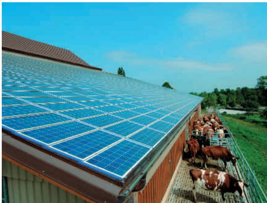
Abb. 1: Mit einer dachintegrierten Photovoltaikanlage kann sowohl Strom erzeugt als auch Dürrfutter warm belüftet werden (Foto: Karl-Heinz Hug).
