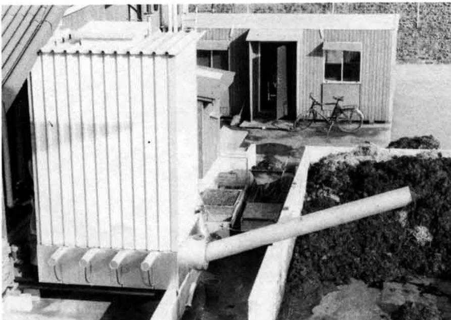
Abb. 1. Anacom-Pilotanlage zur Biogaserzeugung aus Festmist.
