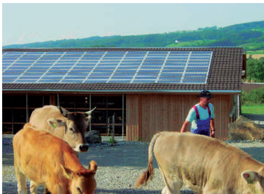
Fig. 8: Une installation photovoltaïque ne demande pratiquement pas de travail, mais nécessite beaucoup de capitaux propres. Dans l'ensemble, le risque d'investissement et la rentabilité sont avantageux. (Photo: Agence Solaire Suisse)
