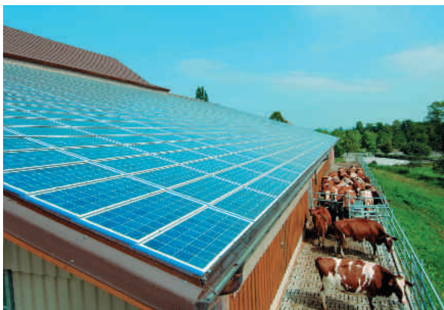
Fig. 1: Avec une installation photovoltaïque intégrée dans la toiture, il est possible de produire à la fois du courant et de ventiler le fourrage sec (photo: Karl-Heinz Hug).
