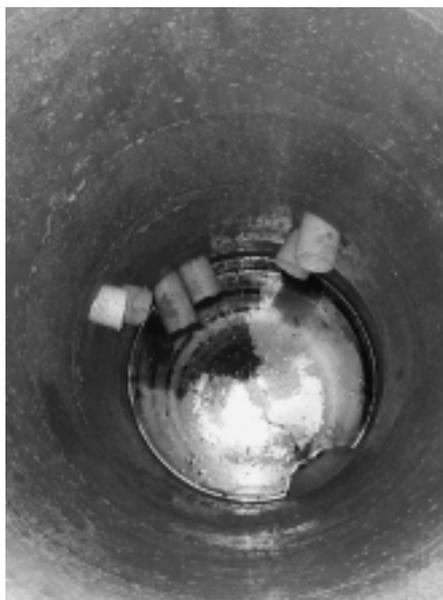
Abb. 4: In Frankreich ist für alle Behältertypen eine Leckerkennung erforderlich. Die Dränageleitungen unter der Bodenplatte laufen in einen Schacht zusammen.
