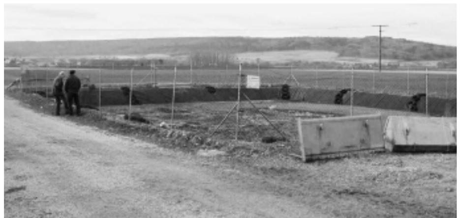
Abb. 19: Sehr kostengünstige Güllelagerung in einem offenen Erdfolienbecken (Betriebe D1 und D3).
