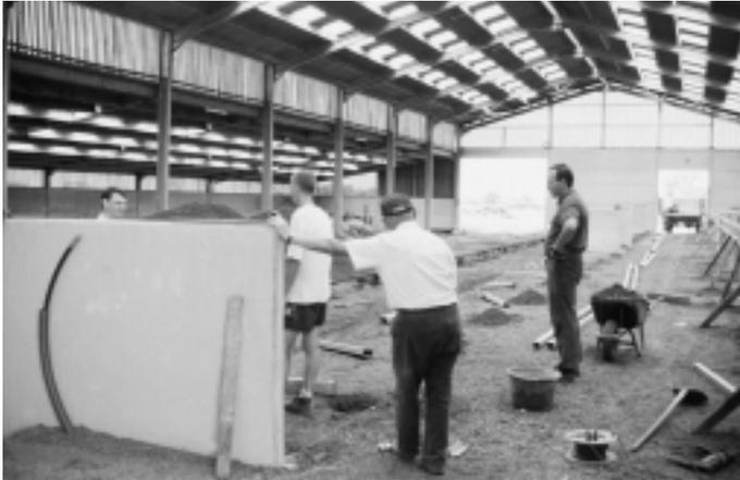
Abb. 14: Aussenklimastall F2. Gleiche Stahlstruktur wie F1. Die Inneneinrichtung wurde zum grössten Teil in Eigenleistung montiert. Reichliches Tageslicht dank den Lichtplatten im Dach.
