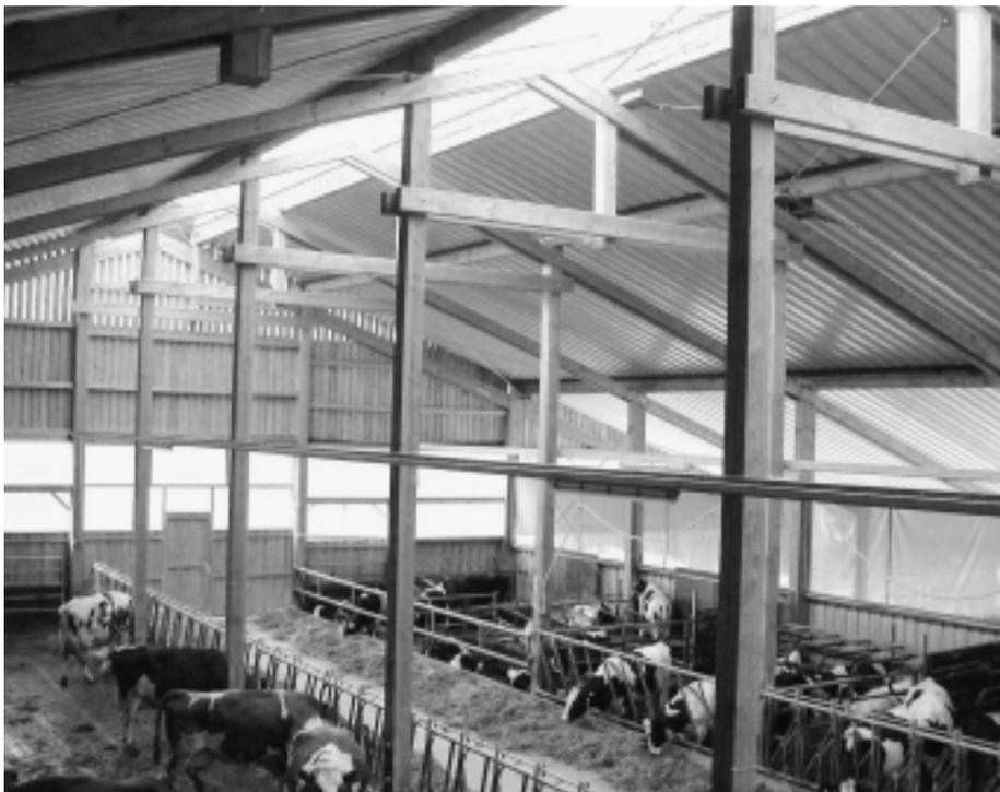
Abb. 1: Geräumiger Aussenklimastall mit einfacher Bauhülle. Schlanke Dachstruktur mit freitragendem Trapezblech.
