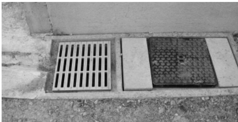
Abb. 2: Um zu verhindern, dass bei einem Gewitter die Grube überflutet, wird ein spezieller Sammelschacht mit zwei Kammern und regelbarem Überlauf eingebaut (déversoir d'orage), der das Gewitterwasser zur oberflächlichen Versickerung abführt.
