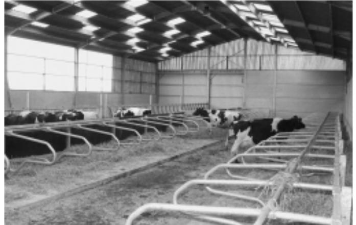
Abb. 15: Aussenklimastall F3. Zentrale Stahlhalle mit einseitigem Anbau. Im Laufgang wird Mist produziert, im Fressgang Vollgülle.
