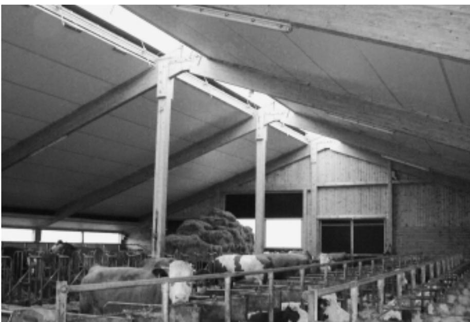
Abb. 10: Wärmgedämmter Stall D2. Die gegenständigen Liegeboxen sind um eine halbe Liegeboxenbreite versetzt. Der Raum zwischen den Bügeln ist für den Hoflader zugänglich (Einstreuen).
