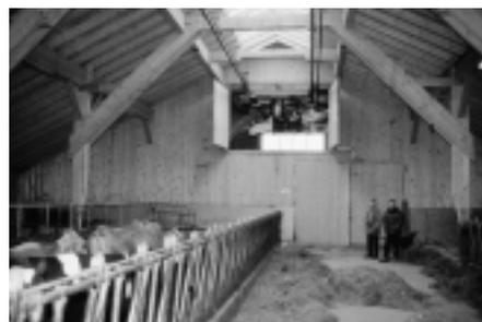
Abb. 5: Blick in den wärmegegedämmten Milchviehstall A1. Eine Öffnung in der Trennwand zur stirnseitig angebauten Heulagerhalle ermöglicht die Beschickung der Futterkrippe mit Auslegerdrehkran.
