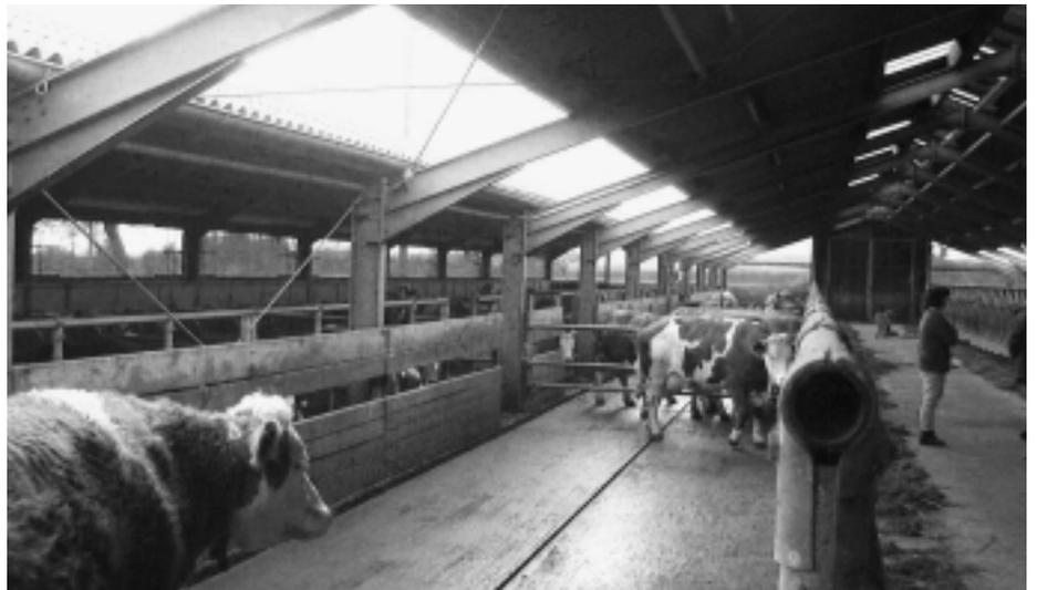
Abb. 12: Aussenklimastall D4. Der Stall besteht aus einer dreischiffigen Stahlkonstruktion mit einer Öffnung über dem Fressbereich. Die Kühe der linken Stallhälfte überqueren beim Melken das Futtertenn.
