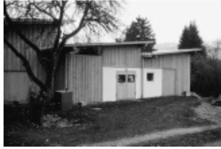
Abb. 8: Aussenklimastall A4. Das Gebäude besteht aus drei aneinander gereihten Pultdächern mit freigespanntem Profilblech.
