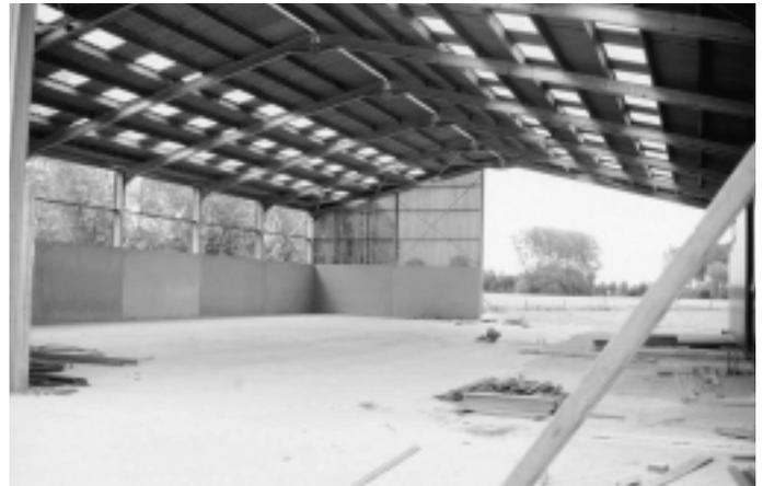
Abb. 17: Überdachter Mistplatz. Eine Überdachung der Mistplatte erlaubt in Frankreich je nach Mistkonsistenz eine Reduktion des Lagervolumens für Jauche (Mistsaft und Meteorwasser) um 25 bis 75%.
