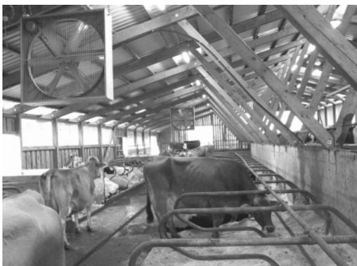
Abbildung 20: Eingebäudestall mit Spaceboard und Windschutznetzen als Wände sowie mit Liegeboxen und angebautem Laufhof (Typ d): Ansicht (links oben), Fressplatz (rechts oben) und Liegebereich (links unten).
