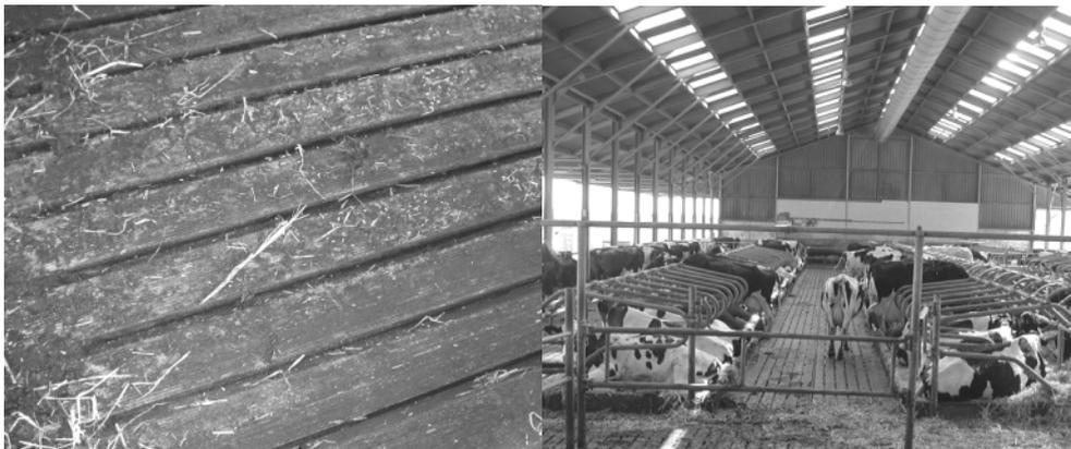
Abbildung 12: Rillenbodenelemente, eingebaut in den Laufgängen eines Stalles in den Niederlanden (Fotos: Van Caenegem, Agroscope FAT Tänikon, 2004).
