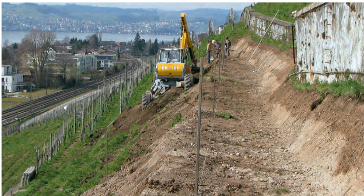
Abb. 2: Umterrassierung mit dem Schreitbagger an der Sternenthalde in Stäfa.
