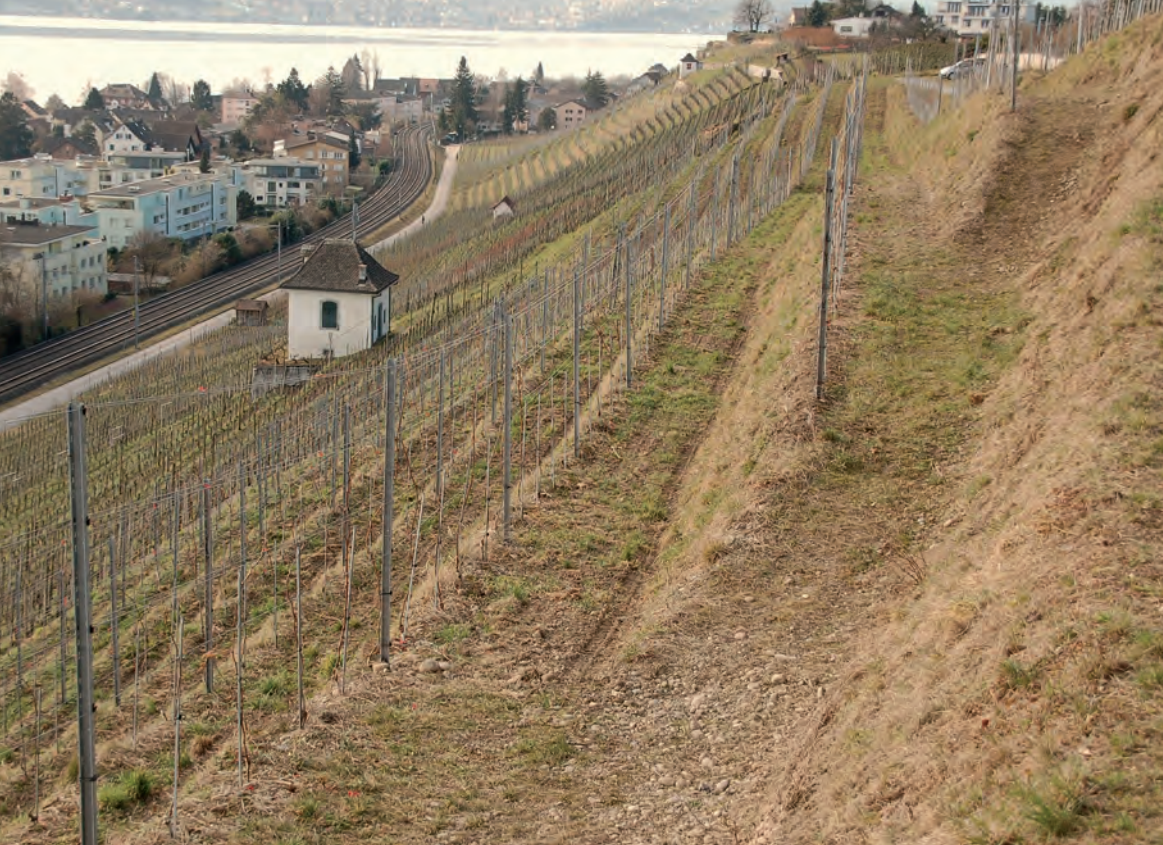
Abb. 3: Terrassenbreite 1.5 m an der Sternenthalde, Mechanisierung mit aufsitzbarer Raupe möglich.
