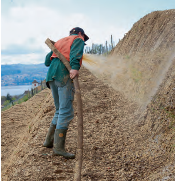
Abb. 4: Hydrosaat: Ein Gemisch aus Samen, Strohhäcksel, Wasser, Leim und Dünger wird auf die Böschung aufgetragen. Es schützt die Erde vor frühzeitiger Abrieselung.
