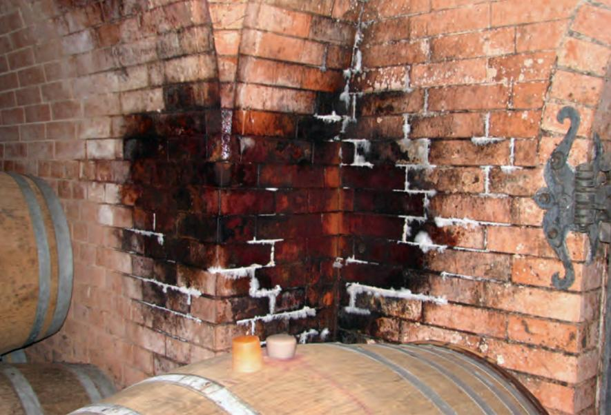
**Abb. 4: Seitliches Eindringen von Aussenwasser in den Weinkeller.**
