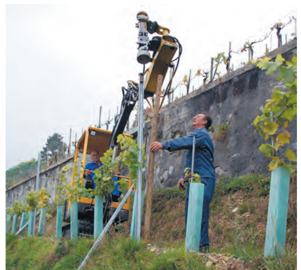
Abb. 2: Erstellen des Drahtgerüsts.
