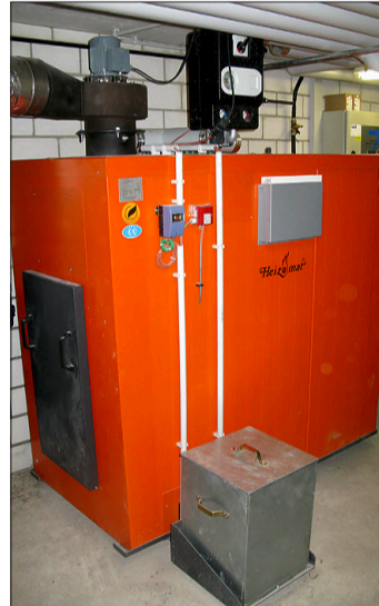
Pilotfeuerung Heizomat RH-AK 35 die seit zwei Jahren zu 100 Prozent mit Miscanthus betrieben wird.
